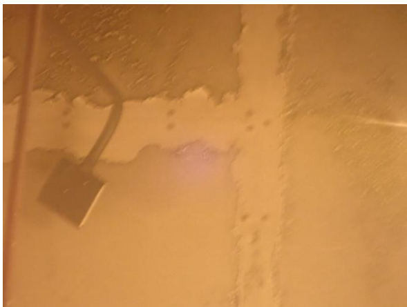
Bild 10: Prüfminute 8: Vollständige Weißfärbung der Oberfläche. Papieroberfläche vollständig verbrannt. Randbereiche der Fugenmasse lösen sich.
