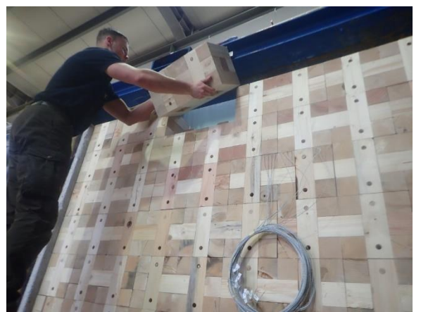
Bild 6: Blick auf einen BRIQ50 nach dem abtrennen der Zapfen und vor dem aufstecken auf die Wandkonstruktion.
