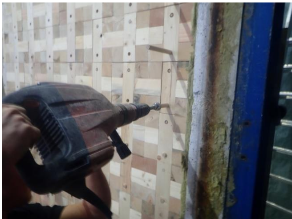
Bild 3: Einpressen der Buchenholzdübel nach der Steckmontage.
