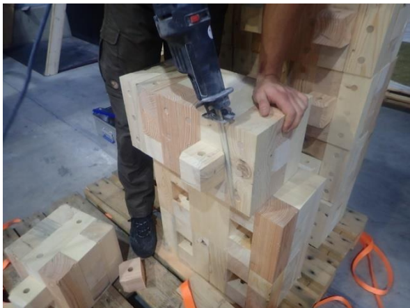
Bild 5: Abtrennen der Zapfen zur Vorbereitung des Wandabschlusses.
