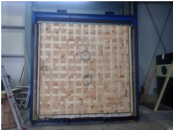
Bild 7: Blick auf die teilmontierte Tragkonstruktion.
