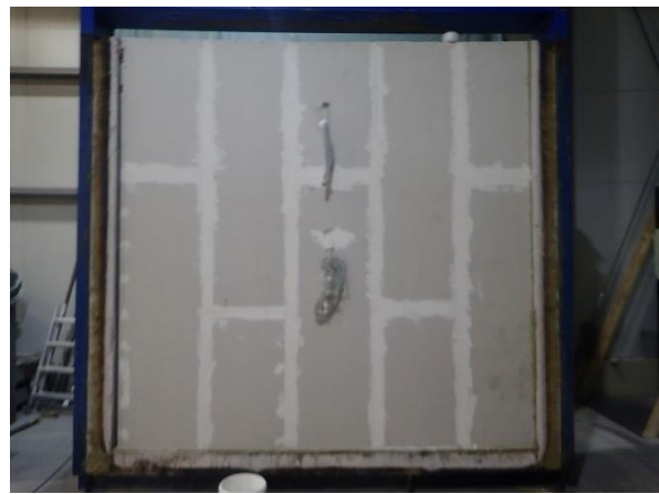
Bild 8: Blick auf die feuerabgewandte Wandseite nach der Montage der Bekleidung/ Beplankung.
