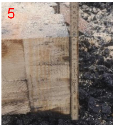
Bild 52: Restquerschnitt am Messpunkt 5 (ca. 185 mm)
