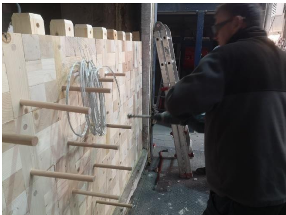
Bild 3: Einpressen der Buchenholzdübel nach der Steckmontage.
