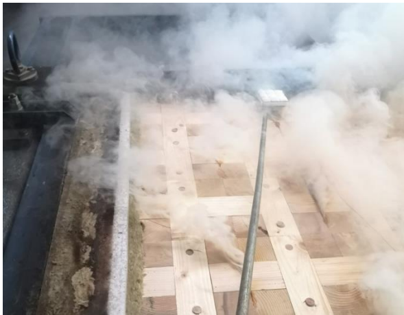
Bild 31: Prüfminute 60: 6. Wattbauschtest im Bereich der Oberflächenmessstelle OF 6, negativ.
