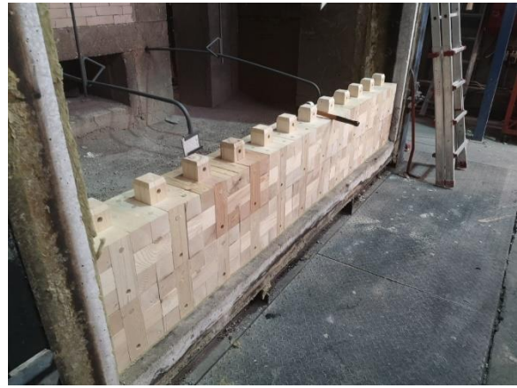
Bild 2: Blick auf die Steckmontage von dem einbringen der Buchenholzdübel zur Sicherung der Verbindungen.
