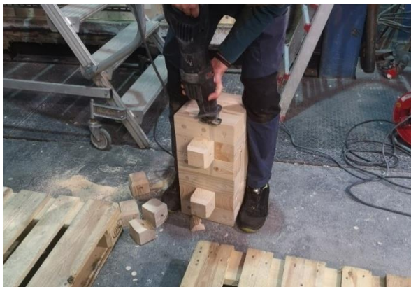
Bild 5: Abtrennen der Zapfen zur Vorbereitung des Wandabschlusses.
