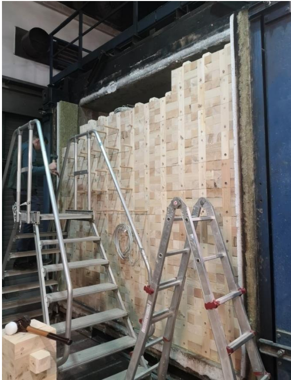
Bild 7: Blick auf die teilmontierte Tragkonstruktion.
