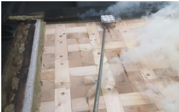
Bild 25: Prüfminute 52: 4. Wattbauschtest im Bereich der Oberflächenmessstelle OF 6, negativ.
