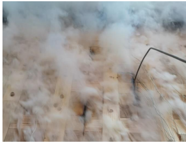
Bild 36: Prüfminute 68: 2. Anwendung der Spaltlehre (6 mm), kann unterhalb der Oberflächenmessstelle OF 8 eingesteckt jedoch nicht geführt werden.
