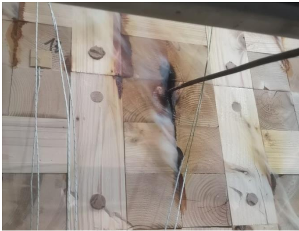
Bild 35: Prüfminute 68: 1. Anwendung der Spaltlehre (6 mm), kann zwischen den Oberflächenmessstellen OF 3 und OF 18 eingesteckt jedoch nicht geführt werden.
