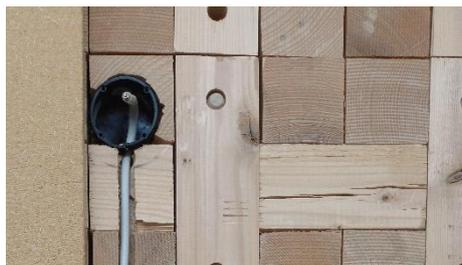
Schlitzen der Wand für Kabelführung
