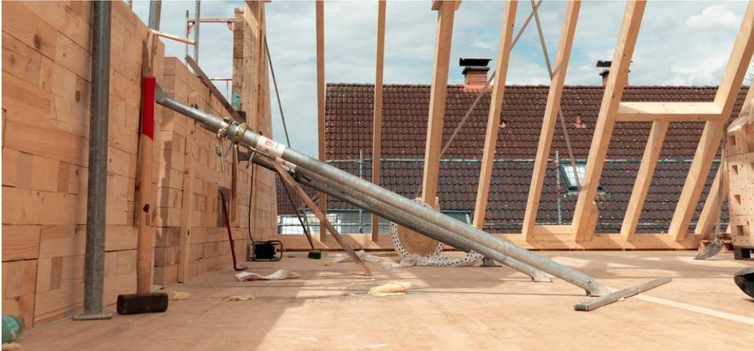
Schrägstützen im Innenraum zur Vertikalabsicherung der Wand
